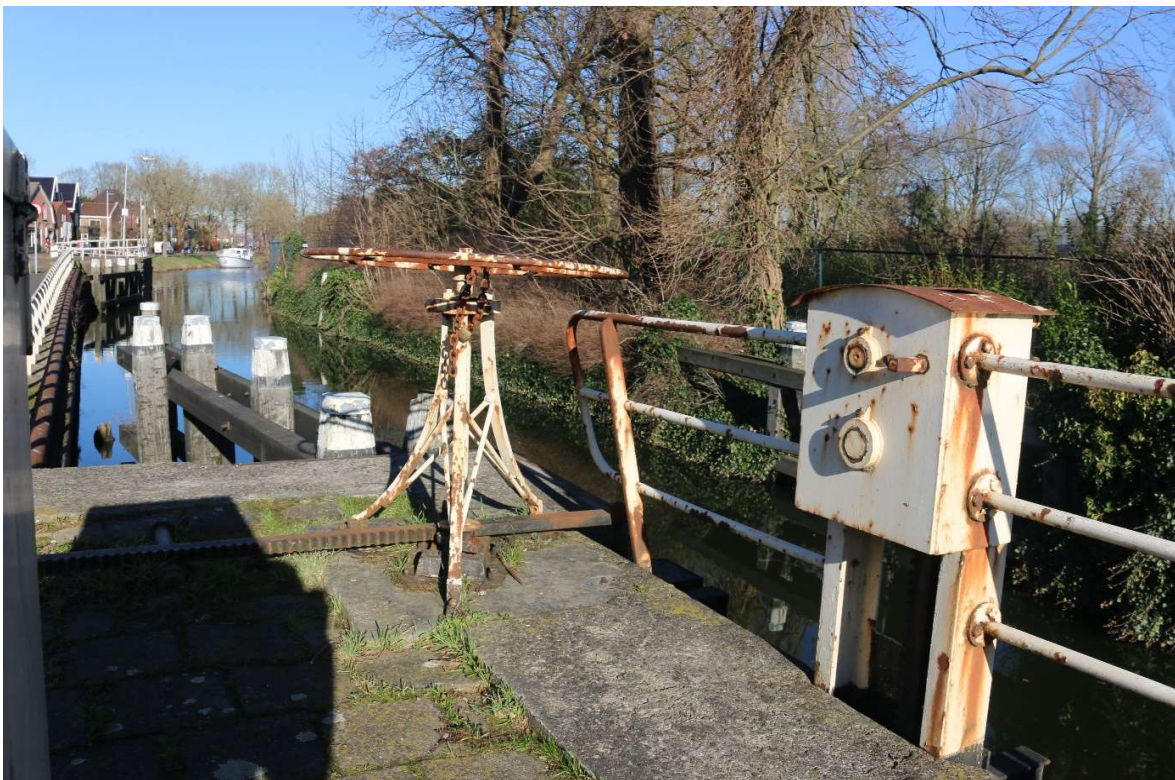
Doorslagsluis (foto HKN)
