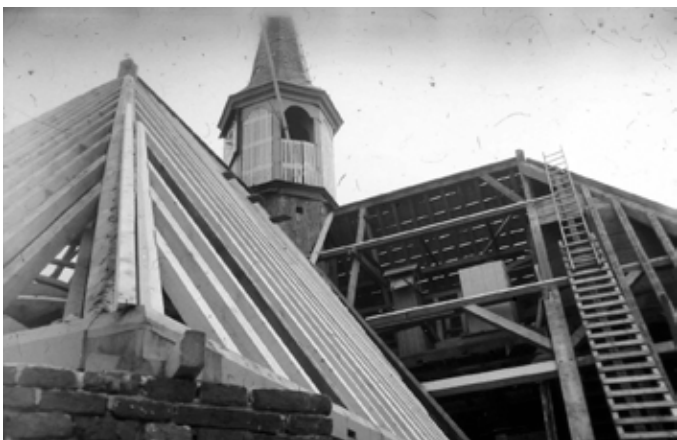
Afb. 19. Zicht op de dakconstructie en de dakruiter. Ca. 1963 (HKN coll. Van Zutphen)
