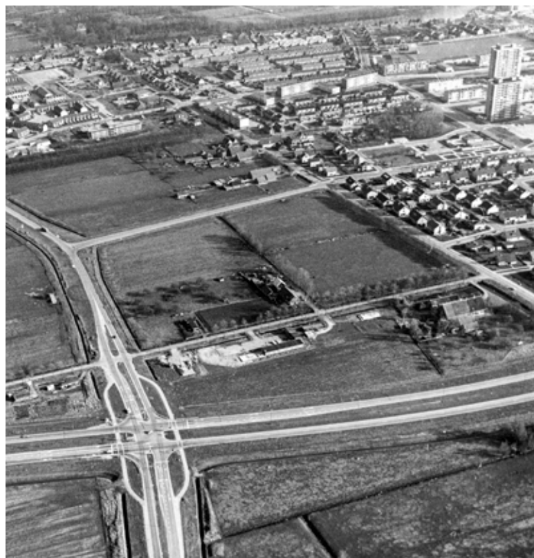
Afb 3. Jutphaas en Jutphaas-Wijkersloot, Zuilenstein in aanbouw, onder nog geen bouwactiviteit in Batau-Noord, gezien naar het oosten, 1976 (Het Utrechts Archief)
