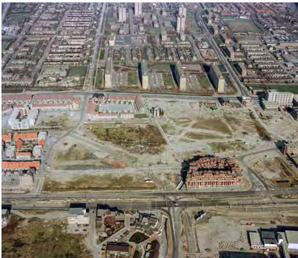
Afb 6. Het Stadscentrum in aanbouw, op de achtergrond Jutphaas-Wijkersloot, gezien naar het noorden, 1983 (Het Utrechts Archief)
