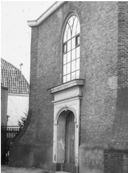
Afb. 8. Dorpskerk met zij-ingang aan de Molenstraat vóór de restauratie in de jaren '60, gezien vanuit de Molenstraat naar het oosten, ca. 1960 (HKN coll. Van Zutphen)
