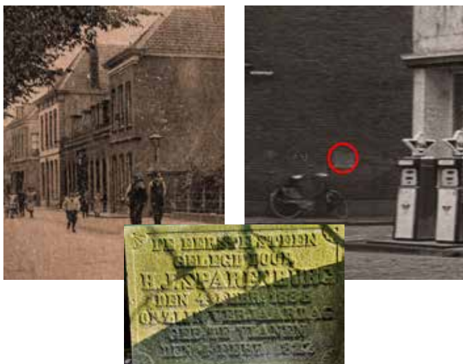
Afb. 14. Gedenksteen met het opschrift 'De eerste steen gelegd door H.J. Sparenburg den 4 febr. 1885 op zijn verjaardag geb. te Vianen den 4 febr. 1822', dat behoorde tot het pand Dorpsstraat 5 (HKN coll. Van Zutphen)
