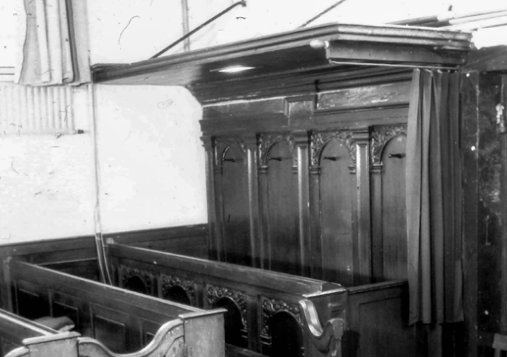
Afb. 13. Herenbank (oorspronkelijke gebruiker niet bekend) aan de westzijde van de noordelijke arm, naast de zij-ingang, ca. 1960 (HKN coll. Van Zutphen)
