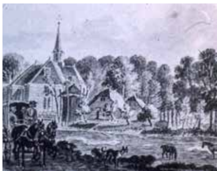
Afb 16. Uitsnede van een 18 e eeuwse prent, met zicht op Vreeswijk vanaf de Lekdijk, gezien naar het oosten. Rechts van de kerk zijn aan De Kade boerderijen en hooiberg te zien [20] (HKN coll. Van Zutphen)
