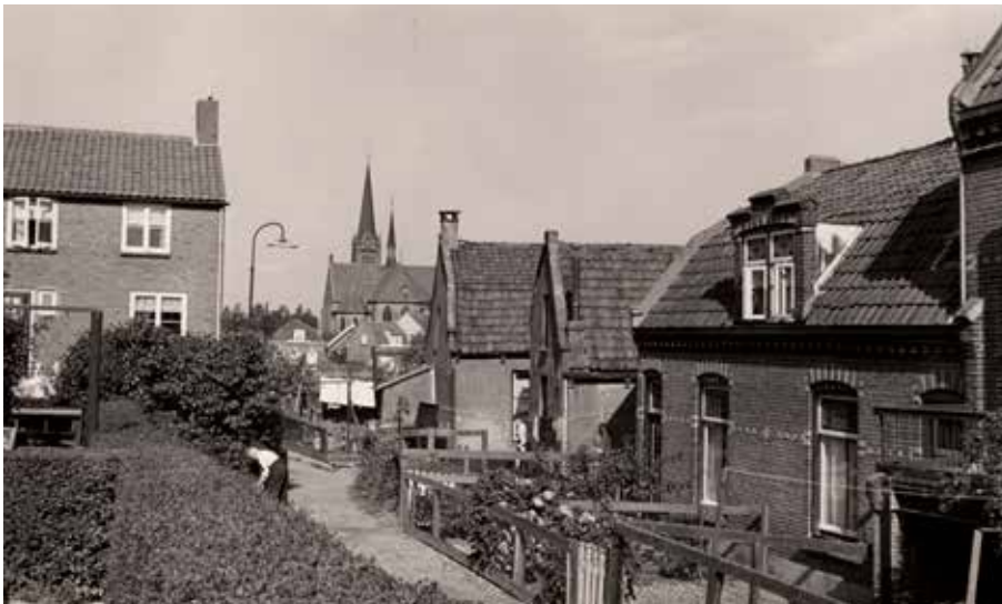
Afb. 10. De Modder, in het verlengde van Het Zand, ter hoogte van Het Bordes, gezien in noordelijke richting. Links een deel van de bebouwing aan de Tramstraat uit 1951. Uiterst rechts nog net een deel van Het Bordes (HKN coll. Van Zutphen).
