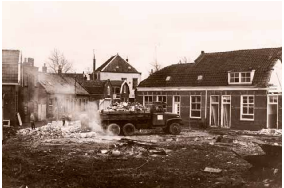
Afb. 18. De sloop van de Schoolstraat, december 1965, gezien naar het oosten richting de Dorpsstraat (HKN coll. Van Zutphen).
