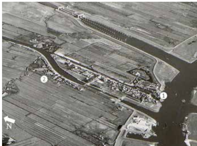
Afb. 2. De dorpskern(en) van Vreeswijk rond de Oude Sluis (1) en aan de Handelskade (2) rond 1940, gezien vanuit het zuidwesten. Op de voorgrond de Veerhaven van de Schipbrug die dan inmiddels niet meer in gebruik is vanwege de nieuwe Lekbrug uit 1936. Daarachter de Koninginnensluis en de (te) kleine Voorhaven, en aan de binnenzijde van de sluis aan het Merwedekanaal de Handelskade waar de tweede dorpskern van Vreeswijk aan is gelegen. Nabij de splitsing van Vaartse Rijn en Merwedekanaal (bij 'De Punt') het Huis De Wiers en scheepswerf Van Zutphen. Zuidelijk daarvan aan de Vaartse Rijn zien we de oude dorpskern rond Oude Sluis en Spuisluis, en het fort Vreeswijk. Op de achtergrond zien we de gloednieuwe voorhaven en de Beatrixsluizen, die aansluiting geven op het Lekkanaal, een zijtak van het Amsterdam-Rijnkanaal.
