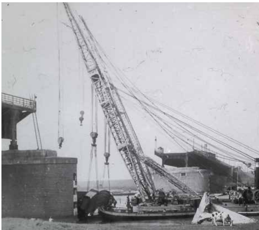
Afb. 6. Delen van de gebombardeerde Lekbrug worden met behulp van een bok uit de Lek getakeld.
