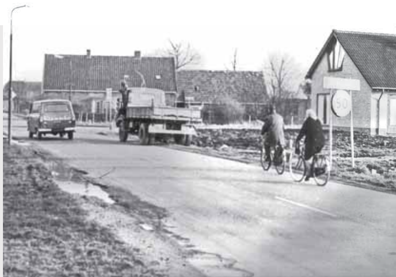
Zicht op de boerderij van de Diaconie aan de Nedereindseweg, vlak voor de sloop (foto: René van der Mark).
