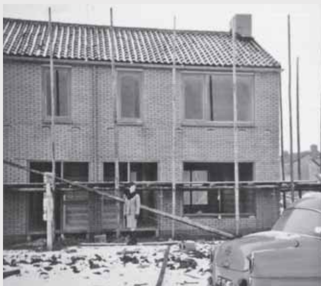
De woning aan de Mendes da Costalaan in aanbouw (foto: René van der Mark).
