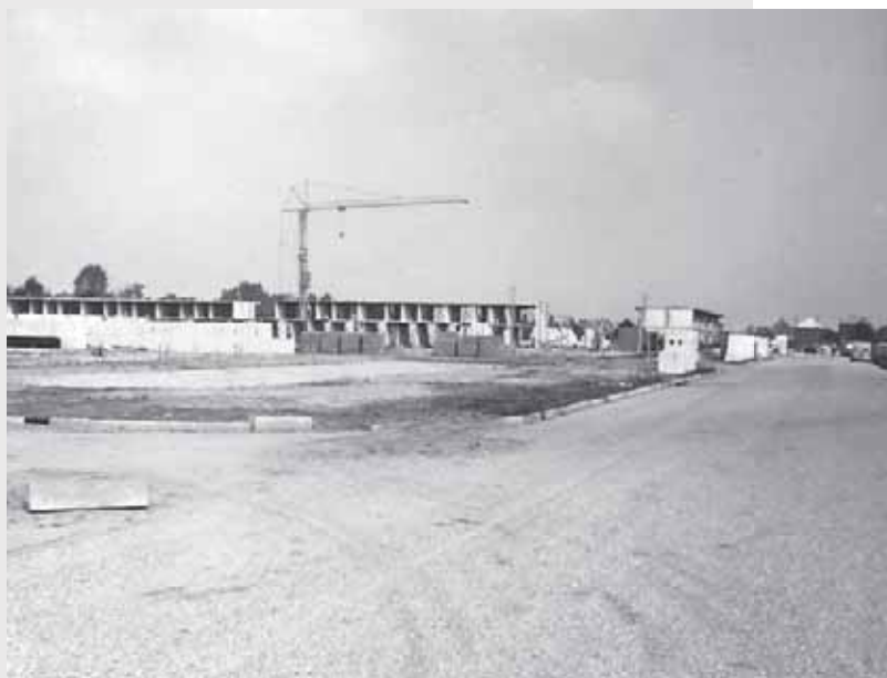
De woning in aanbouw in de Gestellaan (foto: Linda Overes-Janssen).
