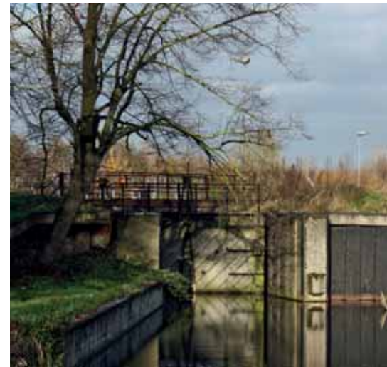
Afbeelding 6: Inundatiesluis in de kade langs het Lekkanaal, gezien over de Schalkwijkse wetting richting het westen (foto auteur, 2013). Zie ook afbeelding 7.
