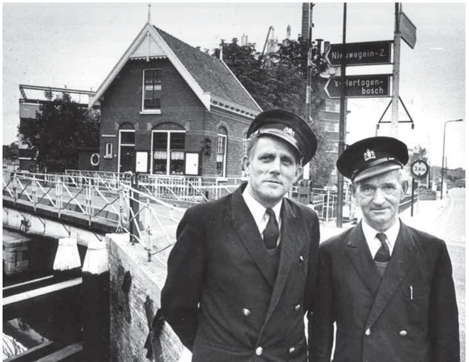
Twee brugwachters, de heren Van Driel (links) en Dubbers, in 1977 gefotografeerd voor de oude Doorslagbrug bij de Henkel fabriek. In dat jaar werd de nieuwe Doorslagbrug bij de Noordstedeweg in gebruik genomen en de oude brug afgebroken. Foto: archief HKN
