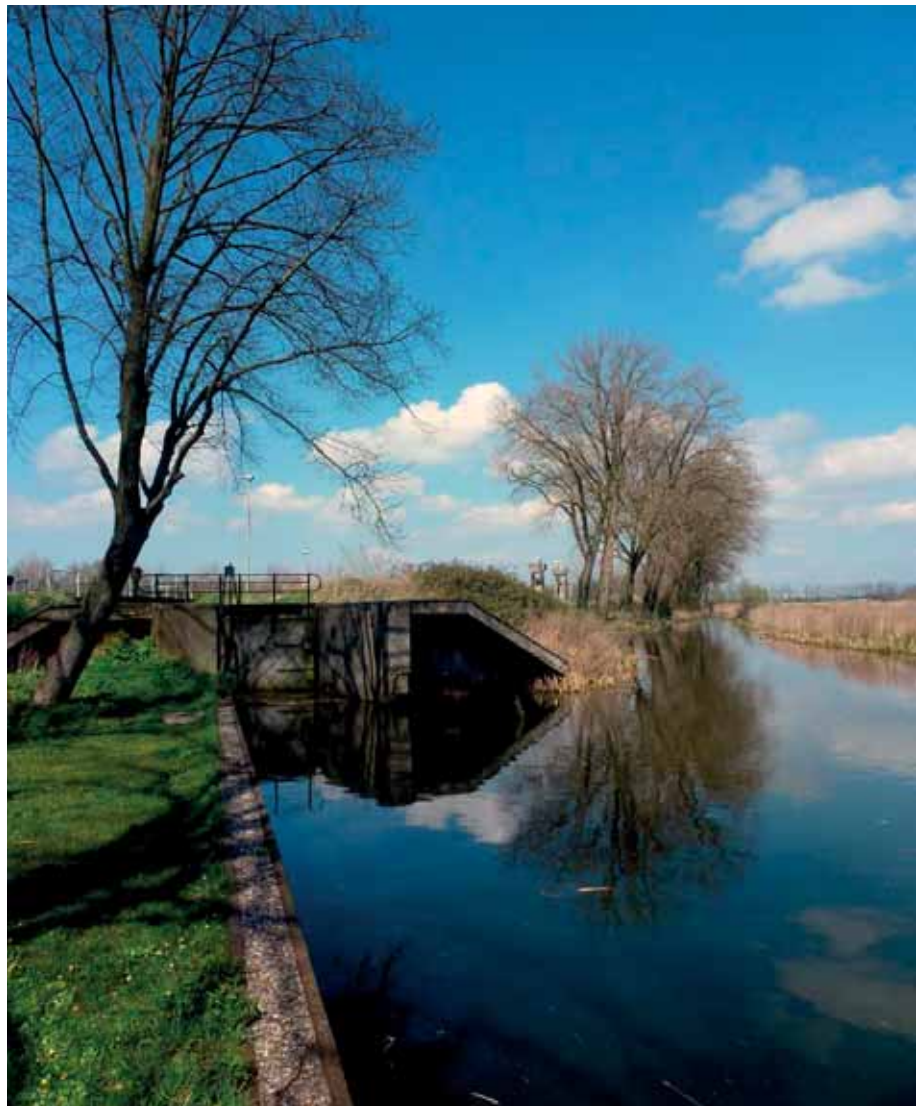
Zicht op de sluis in de Schalkwijkse wetering en de Verlengde Houtense wetering, gezien naar het noorden (2015).
