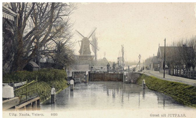
De Doorslagsluis vanaf de brug. Links is nog juist de dakrand zichtbaar van de brugwachter woning, die in 1982/1983 is gesloopt. Rechts de in 1897 gebouwde luiswachterswoning. Links is de oliemolen van Verloop zichtbaar. Deze molen is in 1947 geheel verdwenen. Op de achtergrond is de Wipwatermolen “Oudegein” nog net zichtbaar.
