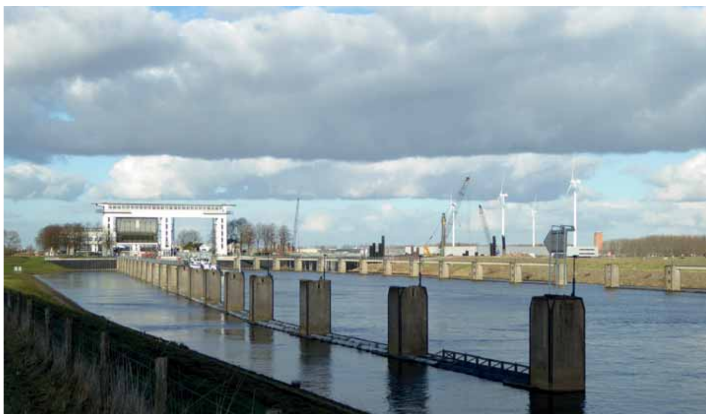
Beatrixsluis en Voorhaven, gezien naar het noorden. Rechts van de sluis zijn de bouwactiviteiten rond de derde kolk zichtbaar.
