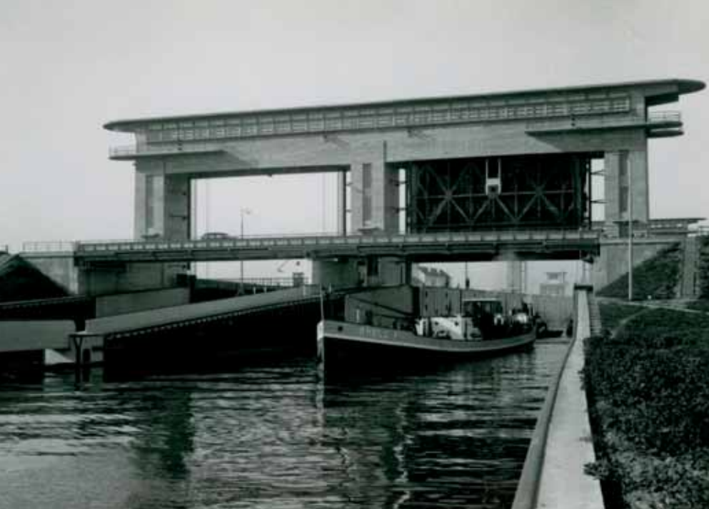
Zicht op de sluis langs het Lekkanaal, richting het zuiden.
