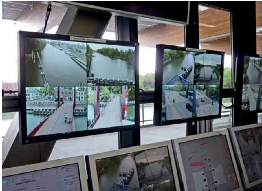
Met vier camera's per brug worden alle verkeersbewegingen nauwlettend gevolgd. Rechts de Blauwe Brug, links de Rijnhuizerbrug en daaronder het elektronisch bedieningspaneel. Foto: Ton Vis
