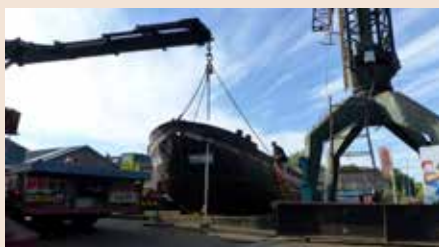
Met een snijbrander wordt de boeg verwijderd. Foto: Cisca de Ruiter
