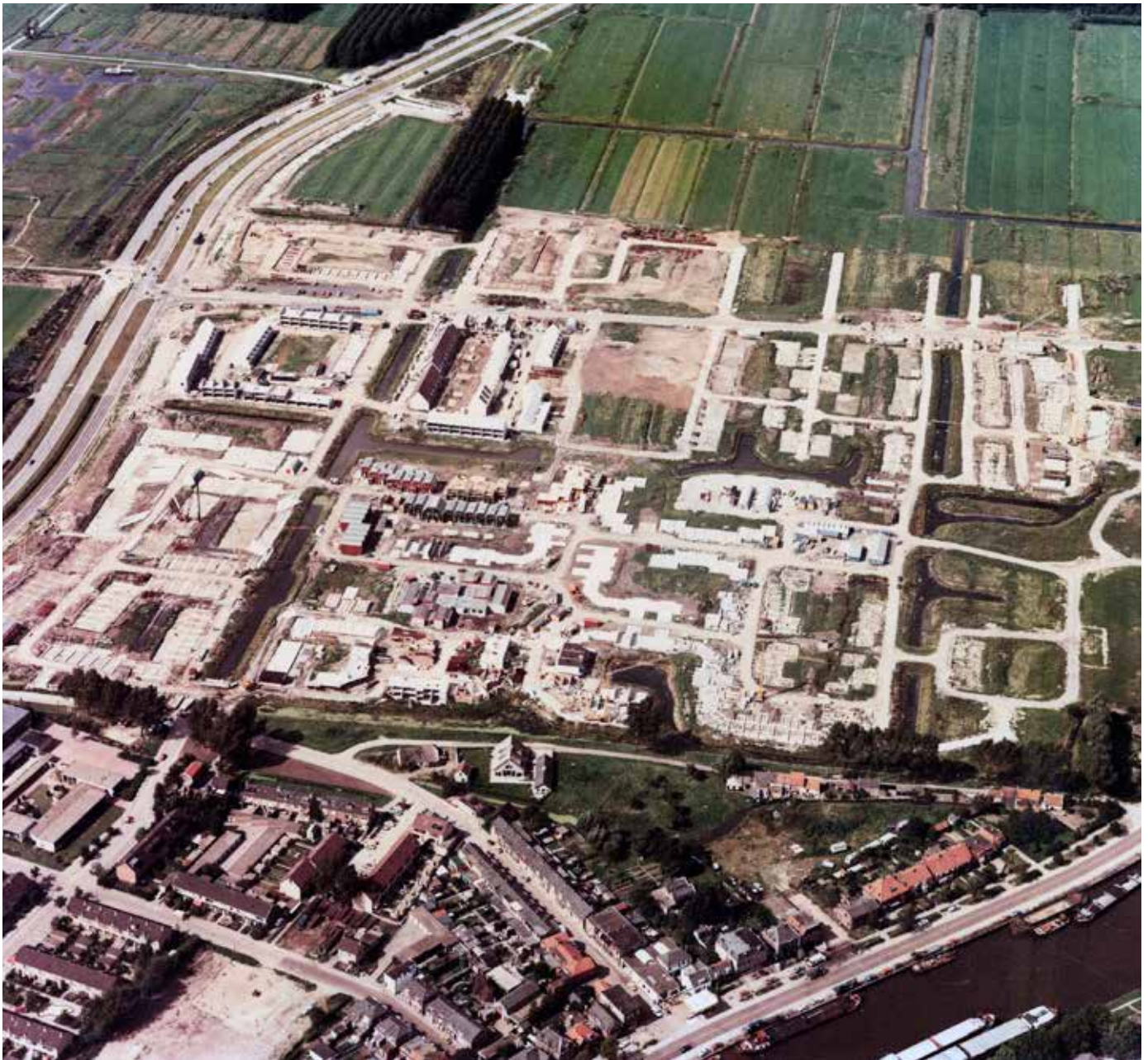
Afb. 2: de wijk Fokkesteeg-Zuid in aanbouw, rond 1980 (collectie Stedebouw gemeente Nieuwegein)
