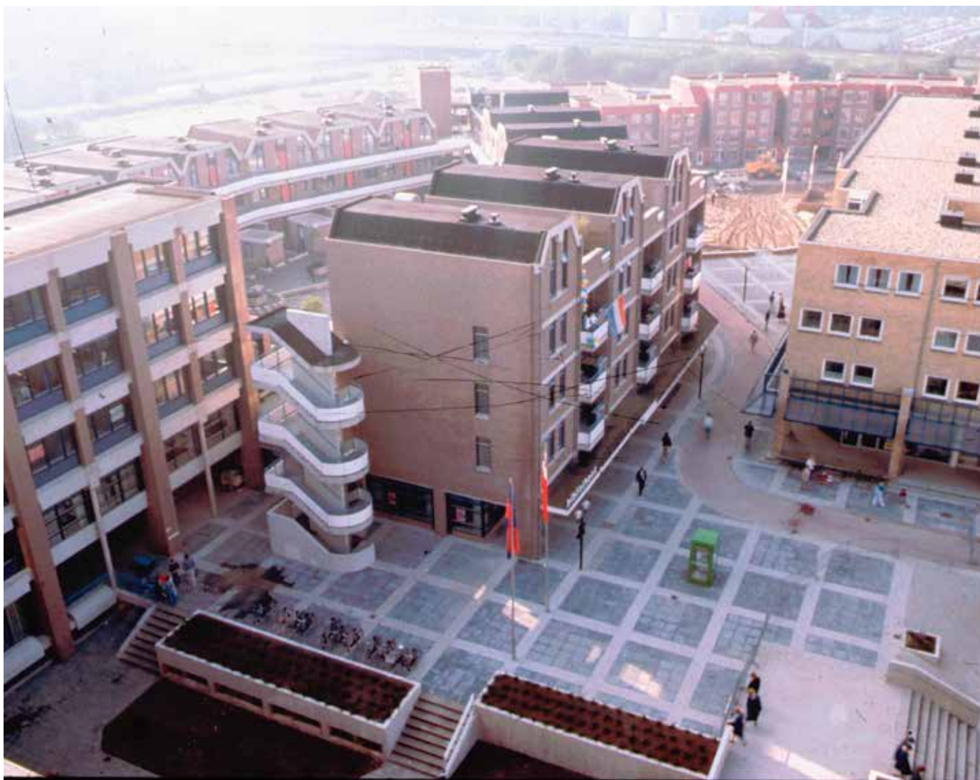
Afb. 3: zicht op een deel van het stadscentrum vanaf het toenmalige gemeentehuis, gezien naar het zuiden. Ca 1985 (collectie HKN)
