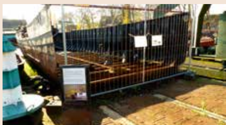
Na het verwijderen van het voorschip krijg je een unieke inkijk in de buik van de Christina, de toekomstige corridor. Foto: Cisca de Ruiter
