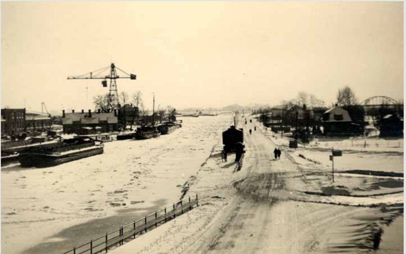
Gezicht op het Merwedekanaal te Jutphaas, vanaf het viaduct van Rijksweg 12, uit het noorden, met links de Scheepswerf en Machinefabriek De Liesbosch N.V. in de jaren '40. Foto: C.Raue sr. - CC BY 4.0
