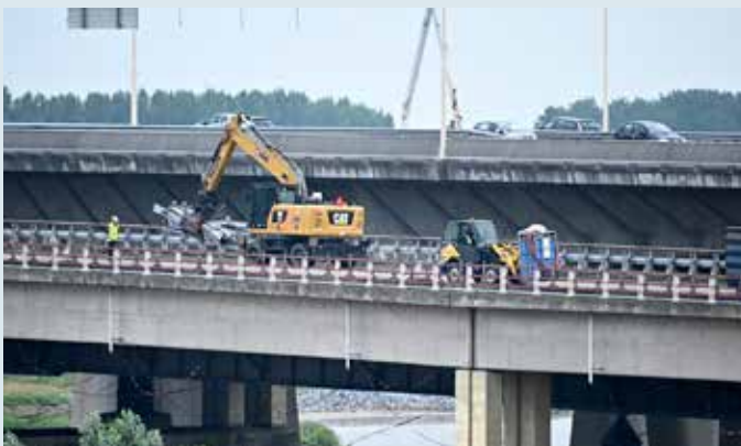
Afgelopen zomer startten de werkzaamheden op en rond de brug ter voorbereiding op het verwijderen van de brug. Foto: Ab Meester
