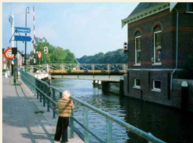
Afb 10. Zicht op de stalen draaibrug en brugwachterswoning, gezien naar het noorden, jaren 1970. Foto: collectie Jaap Boersema
