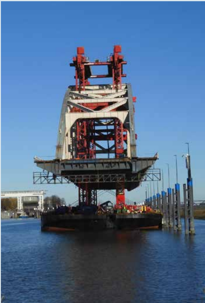
En daar ligt ze dan in de Voorhaven, klaar voor de sloop. Foto: Daan van Dijk
