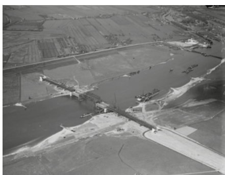
Afb 14. De eerste Lekbrug in aanbouw, gezien naar het noordoosten, jaren 30. Rechtsboven de schipbrug en Vreeswijk (collectie Rijkswaterstaat)
