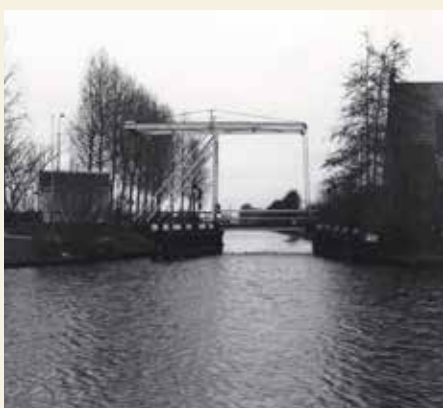
Afb 14. Zicht op de Geinbrug gezien naar het noorden, 1977. Foto: collectie HKN
