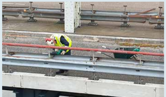
Stukje bij beetje wordt de brug ontmanteld. Als één van de eerste onderdelen moesten de vangrails het ontgelden. De slijptol deed zijn werk. Foto: Fons van Leusden
