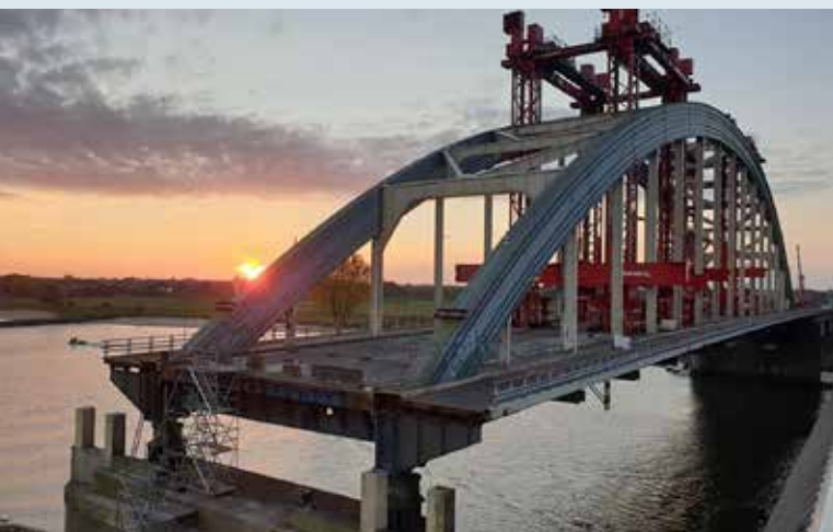
De aanlanding aan de Nieuwegeinse kant is helemaal verdwenen. De rode heftorens van Mammoet worden geplaatst. Hiermee zal de brug over enkele weken in zijn geheel worden opgetild en op een ponton geplaatst. Foto: Fons van Leusden
