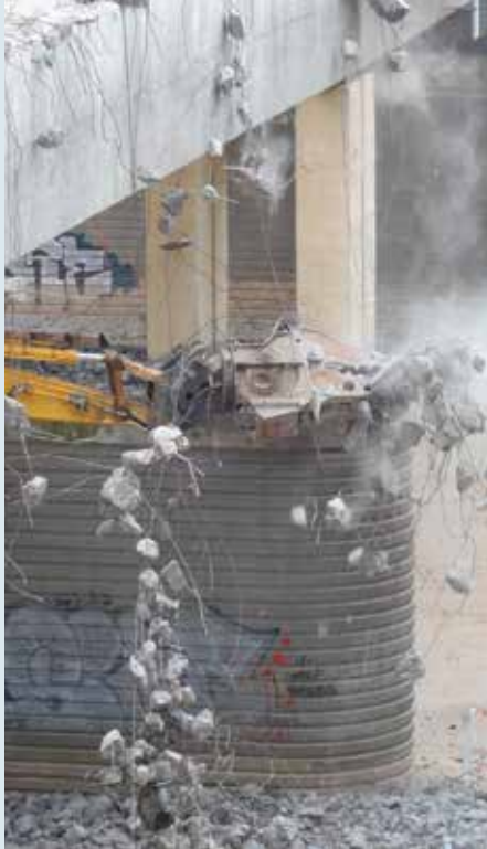
Begin september wordt er al hard geknabbeld aan al het beton dat in de brug zat. Foto: Daan van Dijk
