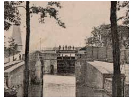
Afb 11. Uitsnede van een ansichtkaart uit de jaren 1920 met zicht op de sluis en de brug, gezien naar het zuiden. Links aan de Lek de Rijkspijlschaal die hier tot in de jaren 1950 heeft gestaan, in de volksmond 'de Peperbus' genoemd (collectie auteur)
