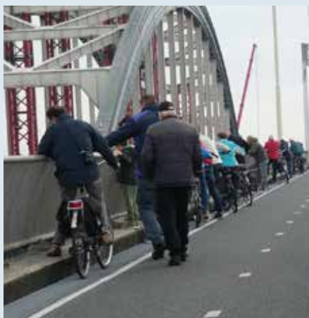
Iedere dag was er aan belangstelling geen gebrek. Vanaf het fietspad op de Jan Blankenbrug hebben zij goed zicht op de werkzaamheden. Foto: Fons van Leusden
