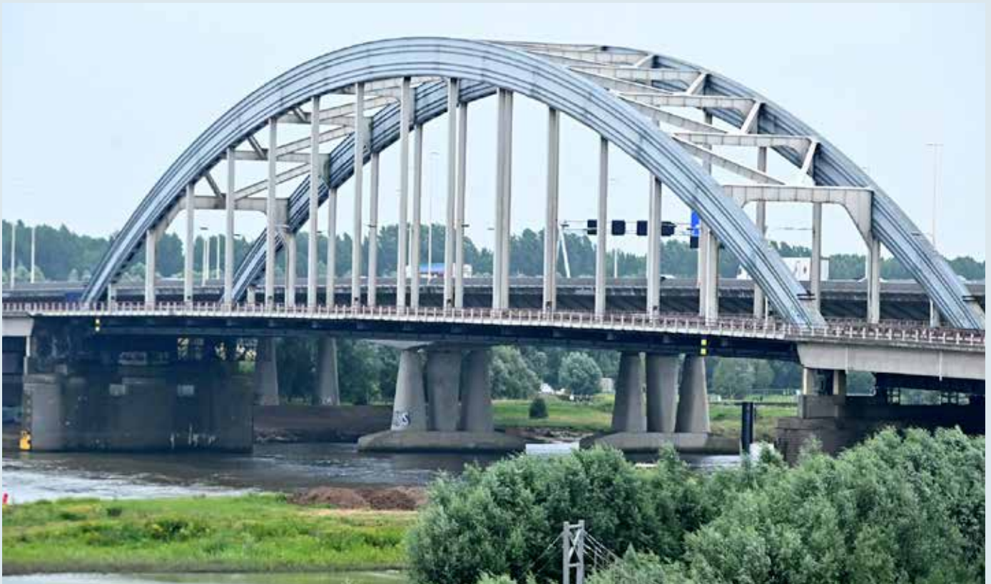
Sinds de opening van de Jan Blankenbrug in 2004 is de boogbrug afgesloten voor al het verkeer. Foto: Ab Meester
