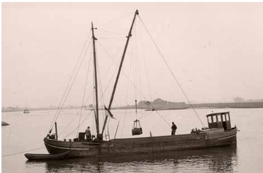
Afb. 2. Een zandschip met zijschroef (een 'lamme arm', een fenomeen dat voor WO2 zijn intrede deed) met gripper aan het werk in de Lek bij Vreeswijk, ter hoogte van het fort, gezien naar het oosten. Het weidse uitzicht over de Lek wordt nog niet beperkt door de A27 en de brug over de Lek. Jaren 1960 (HKN coll. Van Zutphen). Wie herkent dit schip en/of de bemanning?
