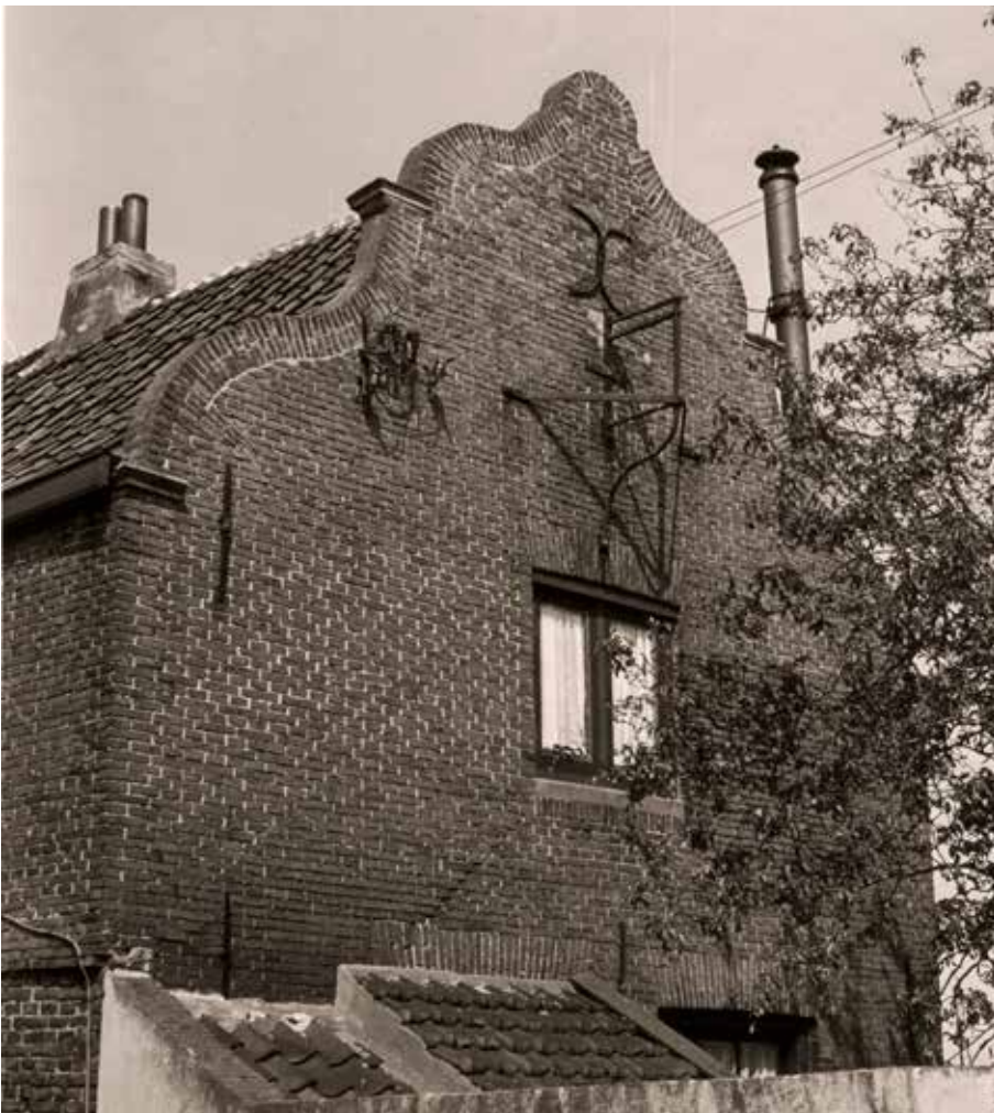
Afb. 6. De sierlijke oostelijke gevel van de orangerie, een zogenaamde 'Gelderse gevel'. Jaren 1960 (HKN coll. Van Zutphen)
