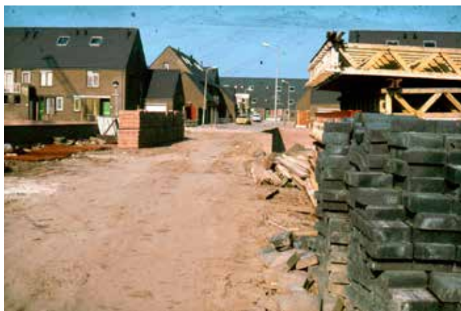
Nieuwbouw in Batau Zuid ten westen van de Batauweg, ca. 1979. (collectie HKN)
