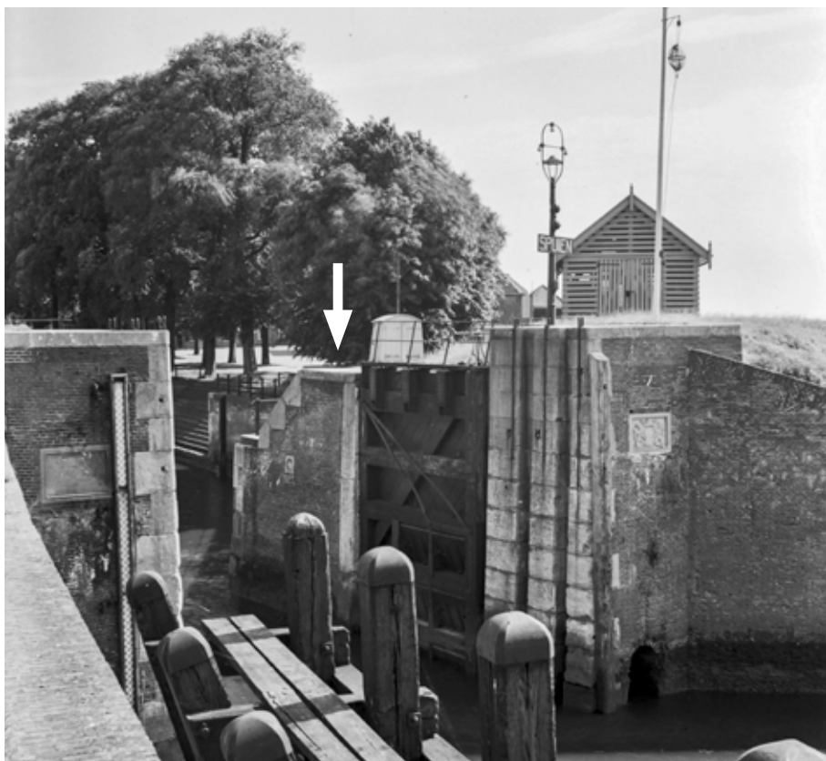
Afb. 13. Foto van het riviersluishoofd aan de Lek in de jaren 1930. De witte pijl geeft bij benadering de locatie aan van het Verlaathuis.
