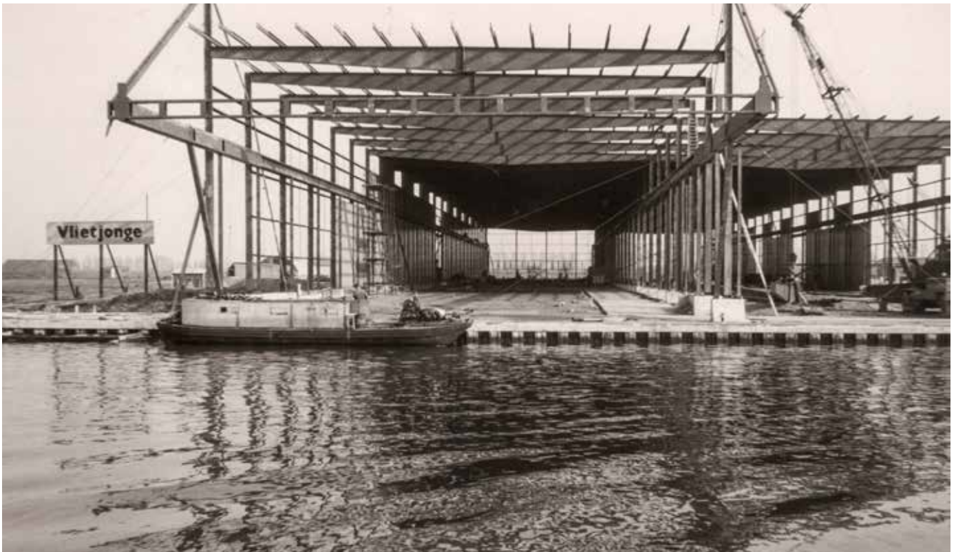
Afb. 8. De bedrijfshal van Vlietjonge aan het Merwedekanaal in aanbouw, naar het oosten gezien vanaf de straatweg naar Utrecht. Begin jaren 1960 (HKN coll. Van Zutphen)
