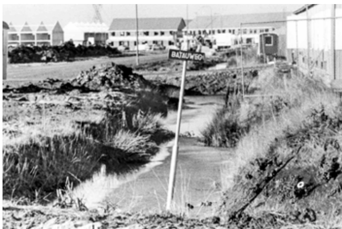
De nieuwbouw ter hoogte van de Kloosterdrift. Deze kwam gereed in de jaren '70. (collectie HKN)
