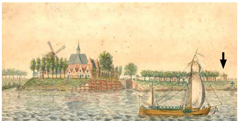
Afb 2. Prent met zicht op Vreeswijk vanuit Vianen, gezien over de Lek naar het noorden. In het midden de gesloten deuren van de Oude Sluis. Rechts is de dubbele bomenrij van Het Laantje te zien - waarmee die naam ook direct verklaard is. Nabij de aansluiting op de Lekstraat staat de hooiberg die behoorde tot [2] (BHIC Toegang 317, inv. 1899)
