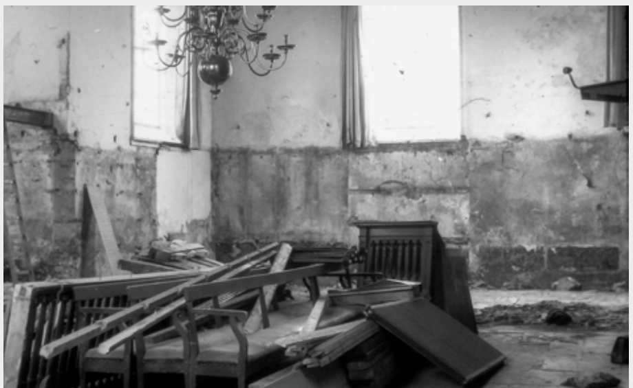
Afb. 17. Indruk van het verrichte sloopwerk tijdens de restauratie 1963-1965. De donkere plekken op de muur markeren de voormalige herenbanken (collectie HKN, ongenummerd)
