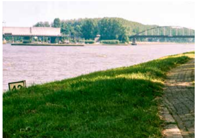
De Plofsluis en de Overeindsebrug in 1994. Gezien naar het zuiden. (Coll HKN, DJ36)
